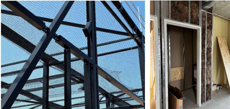
Figure 12: Demountable elements for future reuse at the Van der Sluis transport premises. (Buro De Haan Architectuur / Ontwerp Van der Sluis Transport, 2024)
